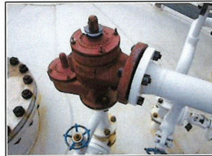
วาล์วนิรภัย PVRV ของถังเก็บก๊าซสารเคมี
