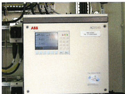
ภาพที่ 2-2 ระบบ CEMs ของ Furnance (F-530)
