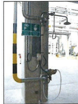
ภาพที่ 2-19 อุปกรณ์ชำระล้างฉุกเฉินในพื้นที่โครงการ (ฝักบัวฉุกเฉินและที่ล้างตาฉุกเฉิน)
