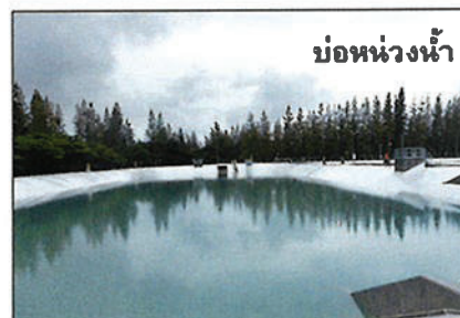
ภาพที่ 2-9 ระบบระบายน้ำภายในโครงการและบ่อหน่วงน้ำ
