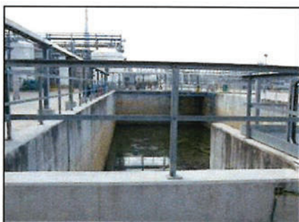
ภาพที่ 2-10 บ่อพักน้ำเสียขนาด 2,000 ลบ.ม.
