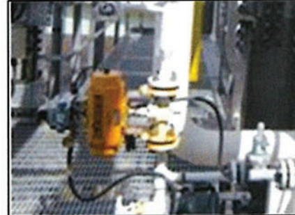
วาล์วฉุกเฉิน (EBV) ของท่อขนส่งสารเคมี
