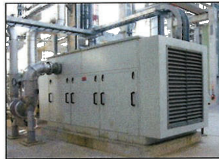
ภาพที่ 2-8 อุปกรณ์ลดเสียงและวัสดุปิดครอบ เครื่องจักรที่เป็นแหล่งกำเนิดเสียง
