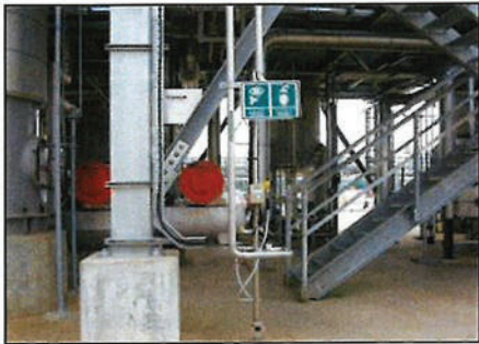
ภาพที่ 2-19 อุปกรณ์ชำระล้างฉุกเฉินในพื้นที่โครงการ (ฝักบัวฉุกเฉินและที่ล้างตาฉุกเฉิน)
